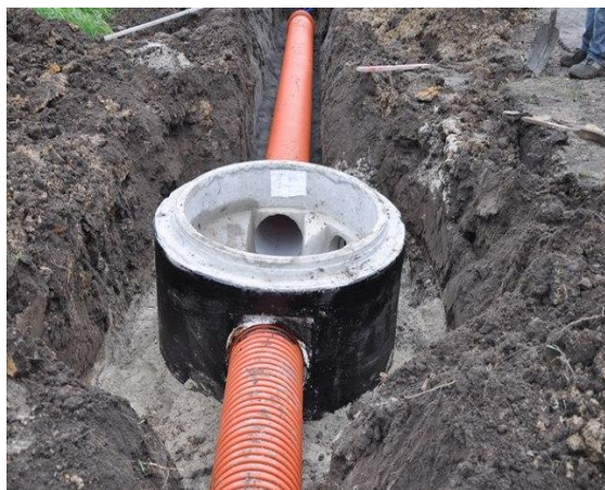
Budowa kanalizacji sanitarnej wraz z wodociągiem na terenie gminy Wolbórz
