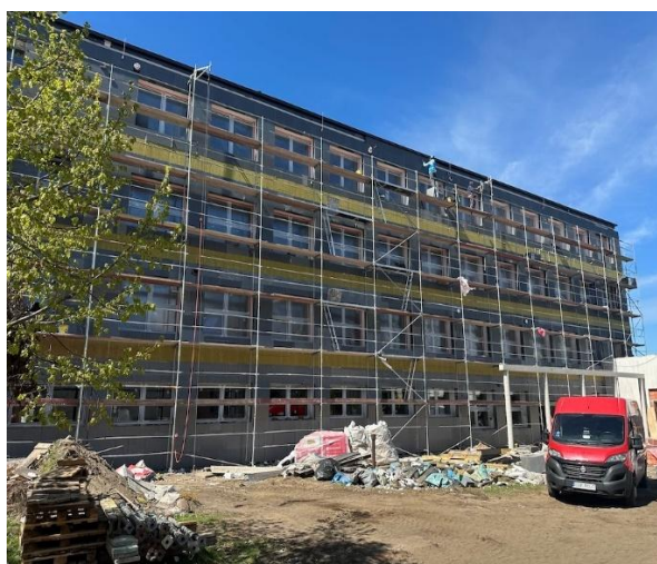
Rozbudowa, przebudowa, nadbudowa i termomodernizacja Szkoły Podstawowej w Wolborzu
