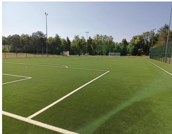
Modernizacja kompleksu sportowego "Moje boisko - Orlik 2012"
