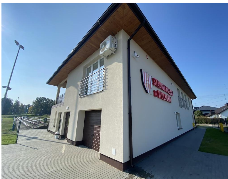
Budynek szatni – Stadion Miejski w Wolborzu
