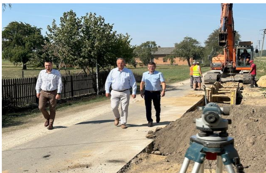
Budowa kanalizacji sanitarnej wraz z wodociągiem na terenie gminy Wolbórz
