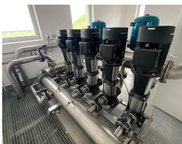
Poprawa zaopatrzenia w wodę mieszkańców Gminy Wolbórz poprzez przebudowę i modernizację ujęć wody wraz ze zdalnym monitorowaniem jej zużycia
