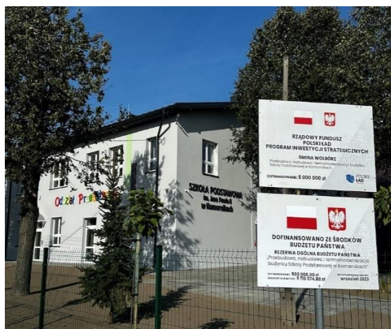
Przebudowa, rozbudowa i termomodernizacja budynku Szkoły Podstawowej w Komornikach
