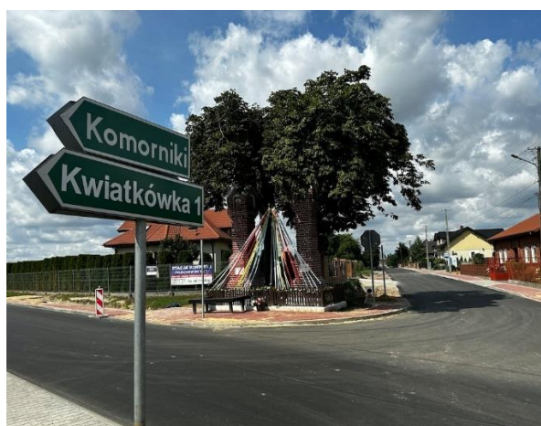
Przebudowa drogi gminnej w Komornikach
